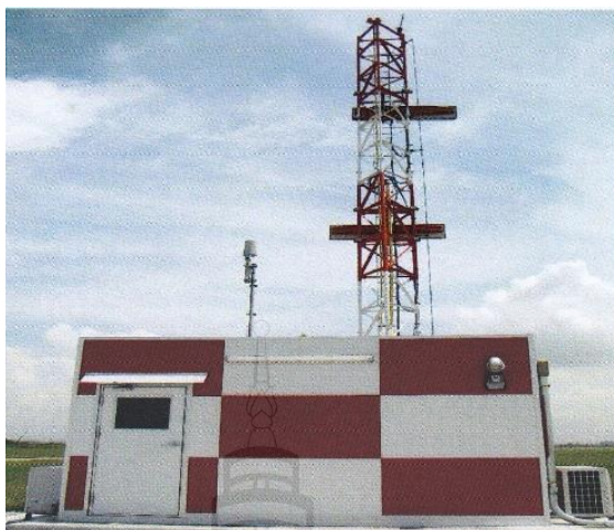
ภาพที่ 2.8 เครื่องช่วยในการเดินอากาศที่เป็นวัตถุ Frangible Object
