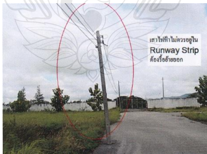
ภาพที่ 4.5 ตัวอย่างเสาไฟฟ้าที่เป็นสิ่งกีดขวางอยู่ใน Runway Strip
