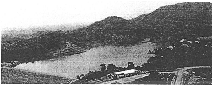
รูปที่ 4-30 อ่างเก็บน้ำสำหรับระบบประปาของมหาวิทยาลัยแม่ฟ้าหลวง
