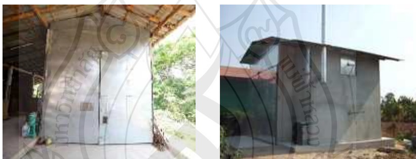
ภาพที่ 4.15 เตาบ่มใบยาสูบแบบประหยัดพลังงาน
