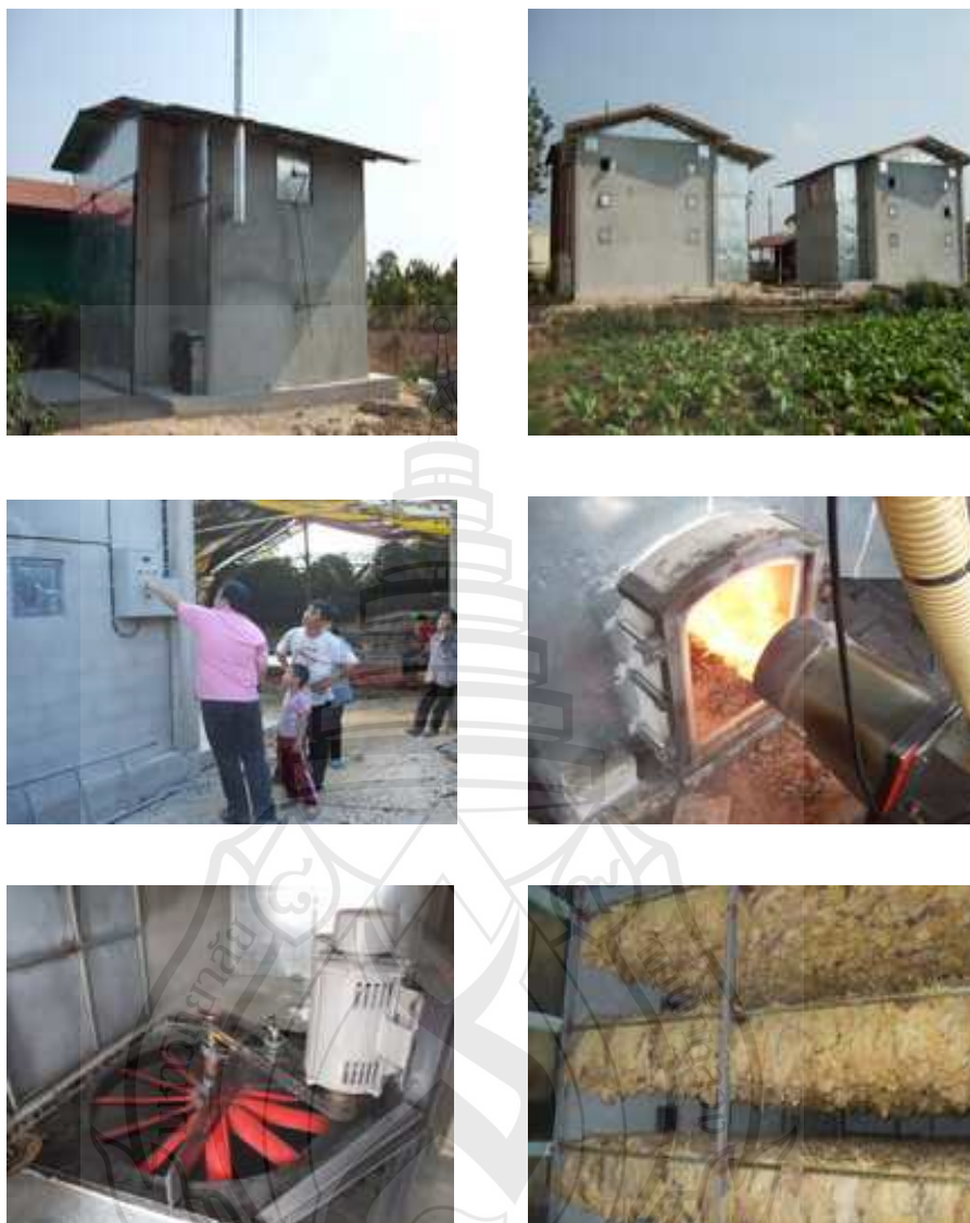
ภาพที่ 4.24 องค์ประกอบของโรงบ่มใบยาสูบแบบปรับปรุง
