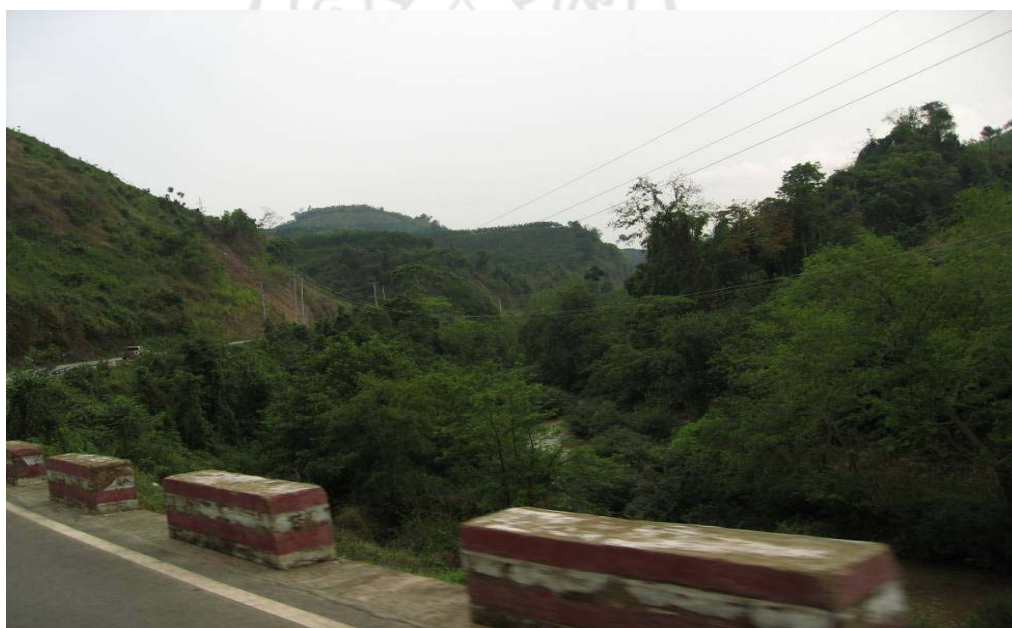
ภาพที่ ค 4 แท่งคอนกรีตใช้เป็นรั้วกั้นถนน บนเส้นทาง R3A หลวงน้ำทา-ป่อเต็น
