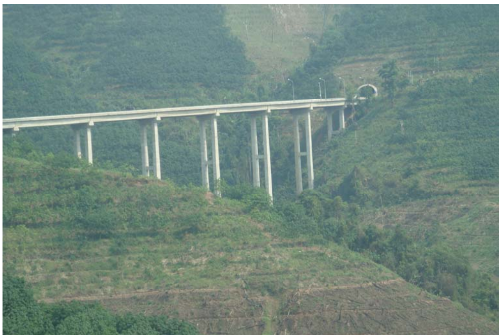
ภาพที่ ค 23 สะพานข้ามรอยต่อระหว่างหุบเหวและอุโมงค์บนเส้นทาง R3A เมืองหลุน
