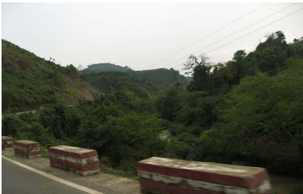
ภาพที่ ค 13 แท่งคอนกรีตใช้เป็นรั้วกั้นถนน บนเส้นทาง R3A หลวงน้ำทา-บ่อเต็น
