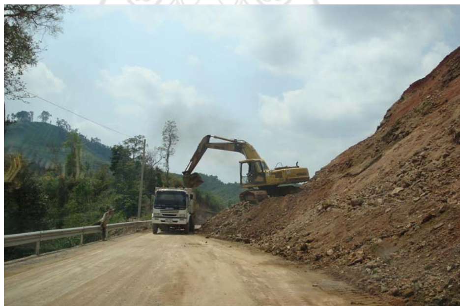
ภาพที่ ค 12 ไหล่ทางพังทลายกินพื้นที่เข้ามาถึงเส้นกึ่งกลางถนนต้องใช้รถแบคโฮเพื่อโกยดิน
