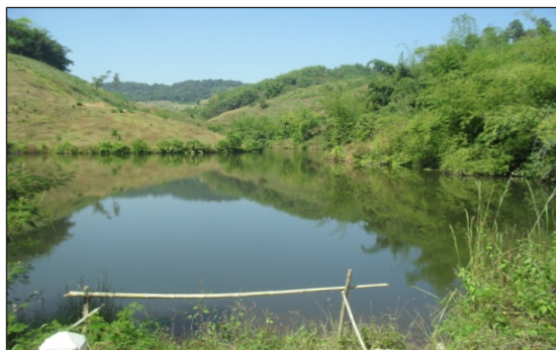
ภาพที่ 4.10 อ่างเก็บน้ำห้วยหม้ออ่าง 1
