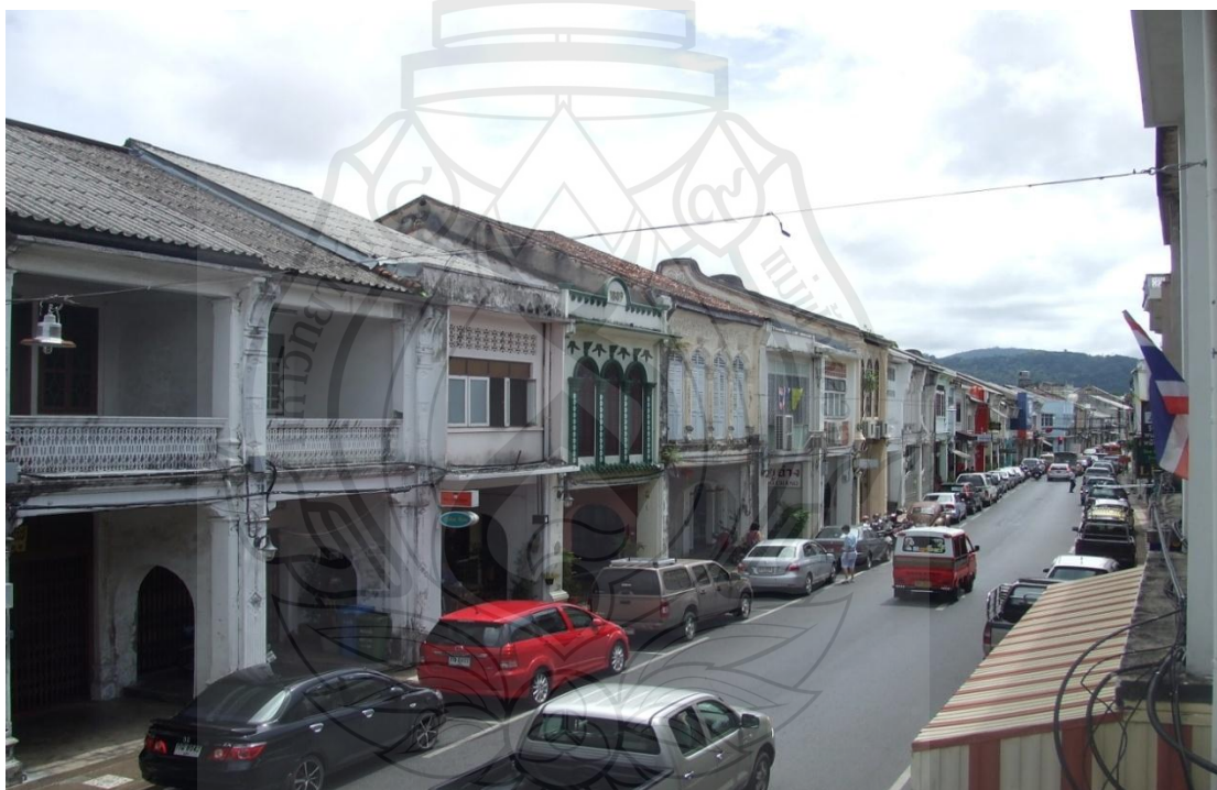
ภาพที่ 4.2 อาคารตึกแถวสถาปัตยกรรมแบบชิโนโปรตุกีส บนถนนกลาง จังหวัดภูเก็ต
